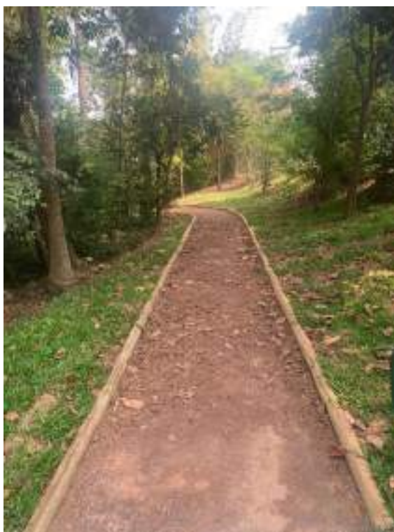
Figura 27: Manutenção rampa de acesso (depois)
