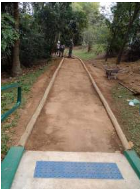
Figura 26: Manutenção rampa de acesso (durante)
