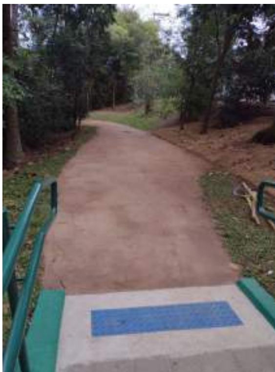
Figura 25: Manutenção rampa de acesso (antes)
