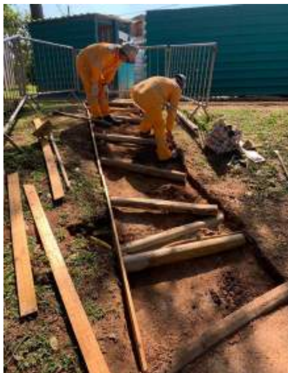
Figura 39: Instalação de escada (depois)
